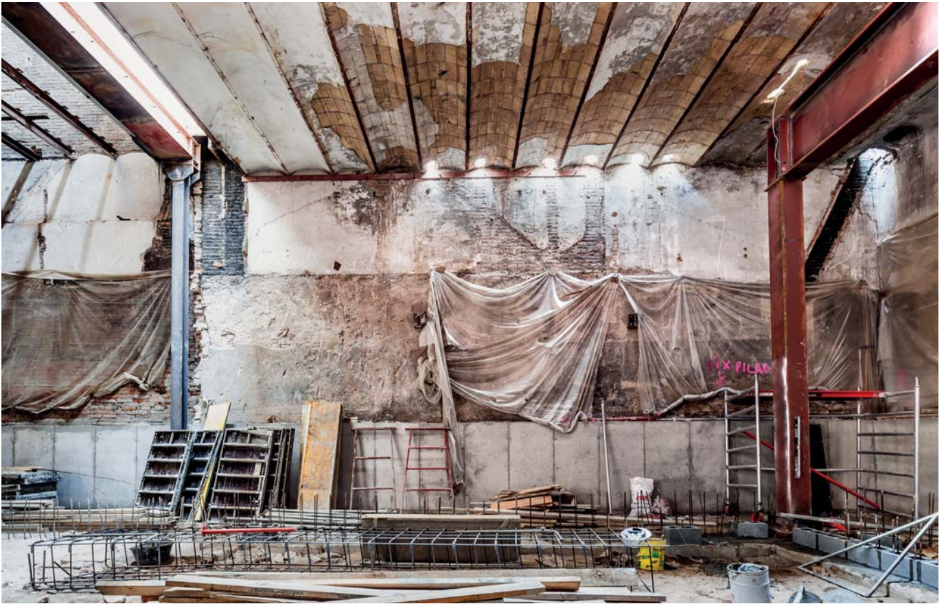
Re-edificatoria Adrià Goula
